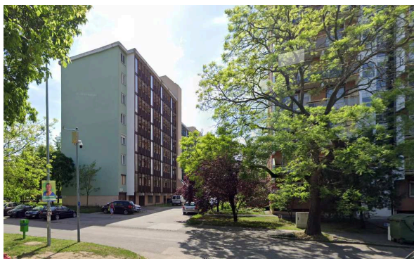
Lakótelep beépítése a Jeney utcában
