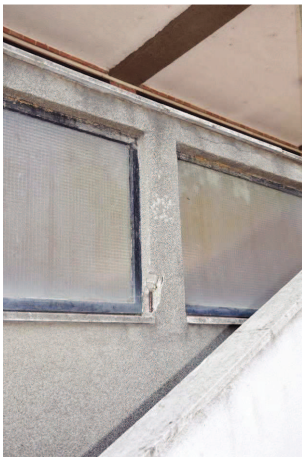
Üveg-vasbeton mellvéd részlete a loggián.
