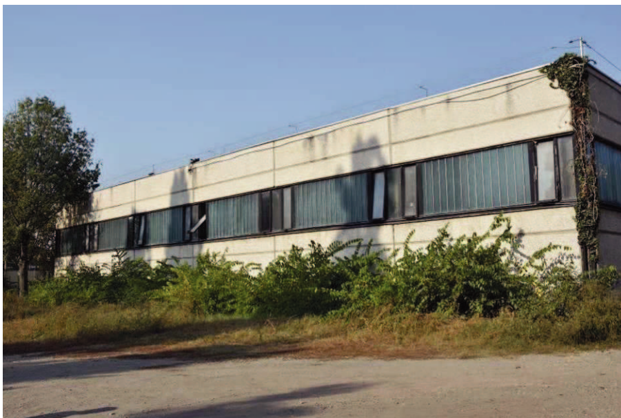
Az épület délkeleti homlokzata,
