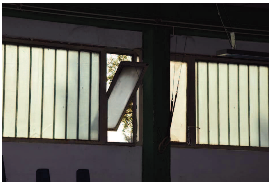
A délkeleti csarnok ablakrendszere; copilit-üvegezés és acél bukóablak.
