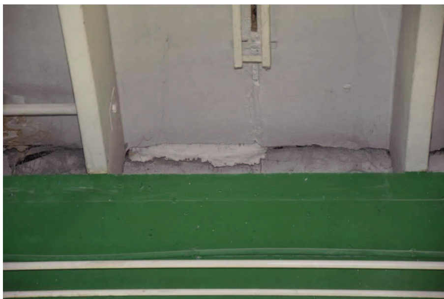
Utólagos tömítés a tetőpanel mellett.
