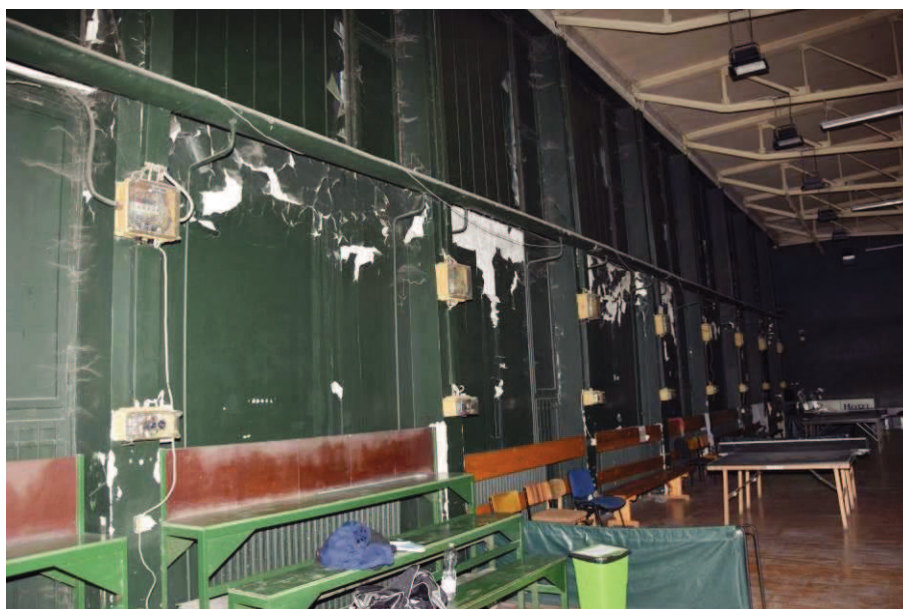
A középső épület ablakszerkezete – azaz ami most látszik belőle. Árnyékolt copilit- üvegezés, vasszerkezetben.
