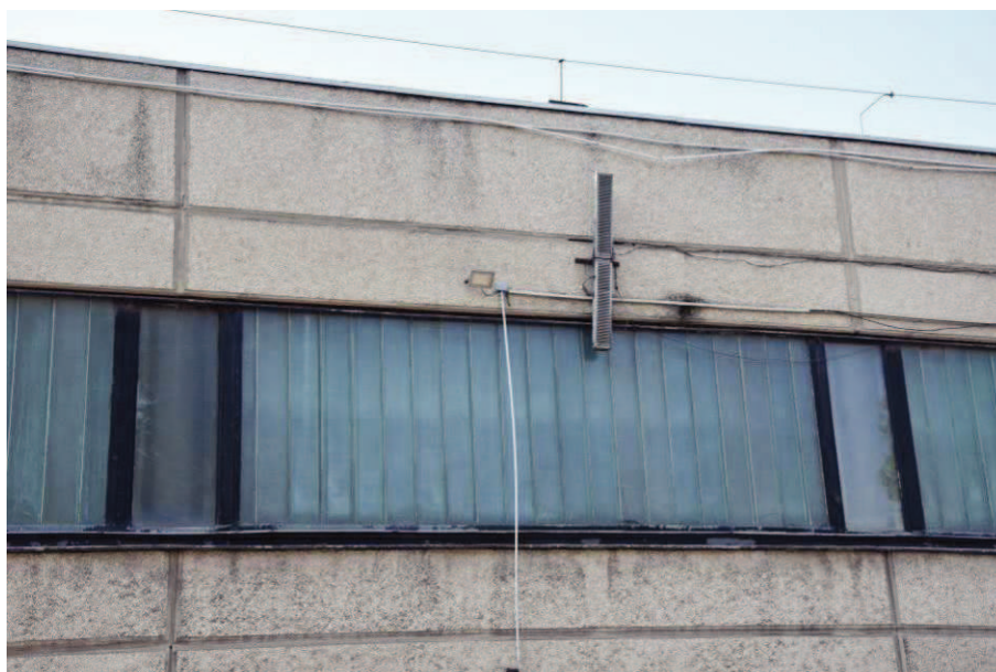
Panel, ablak és copilit-üveg felületek találkozása a délkeleti csarnokon.
