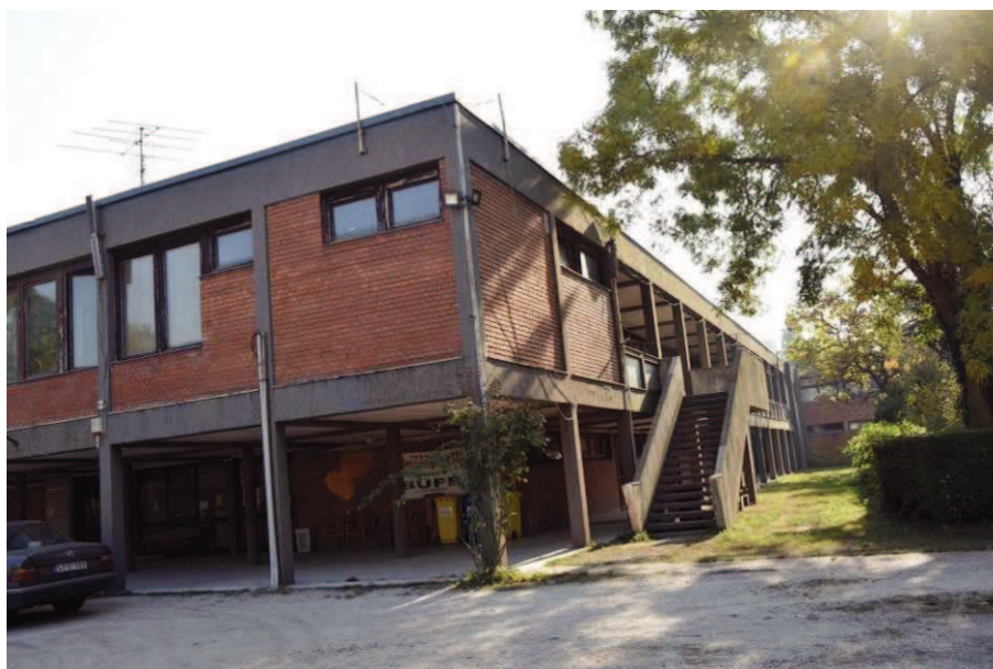
Az együttes északnyugati sarka és a nyugati oldali lépcső a loggiára. Pofafalak közötti vasbeton lépcső-
