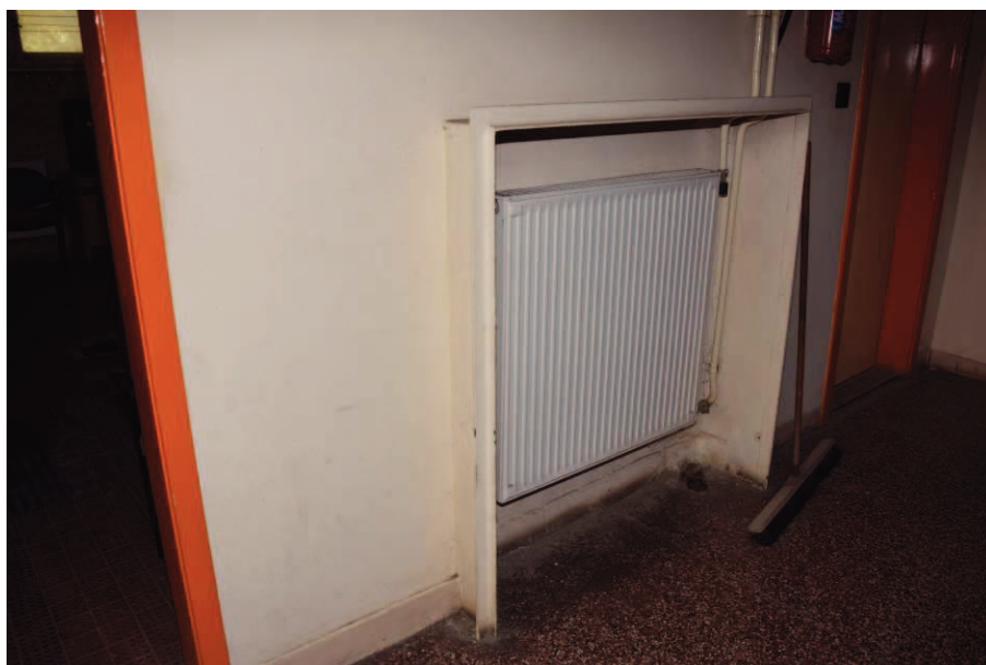
Radiátor eredeti keretezése. A radiátor új.
