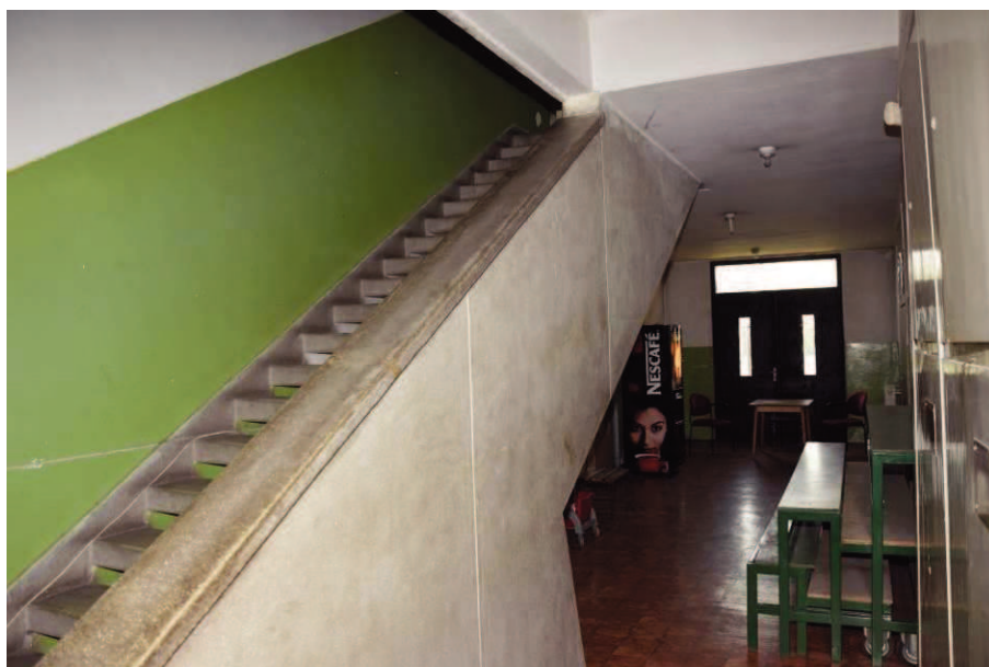
A középső épület bejárata, a felvezető lépcsővel.
