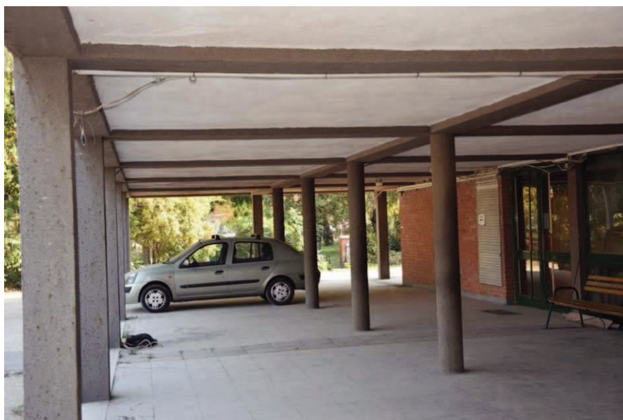
Az északnyugati bejárat előtere északkelet felé nézve. Betonváz. alul festett felület.
