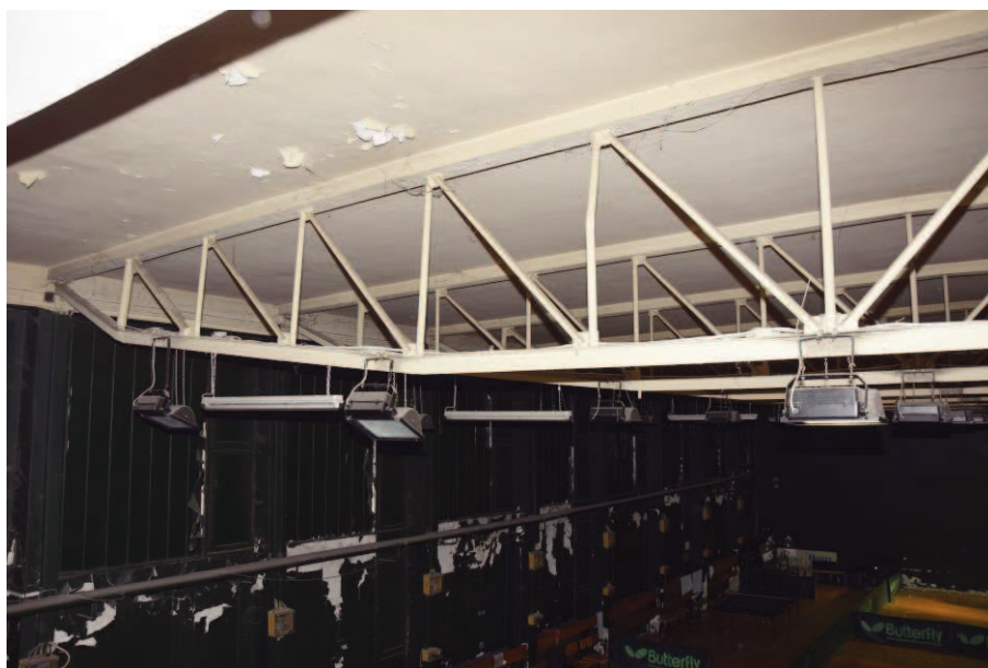
A középső épület rácsostartós tetőszerkezete.
