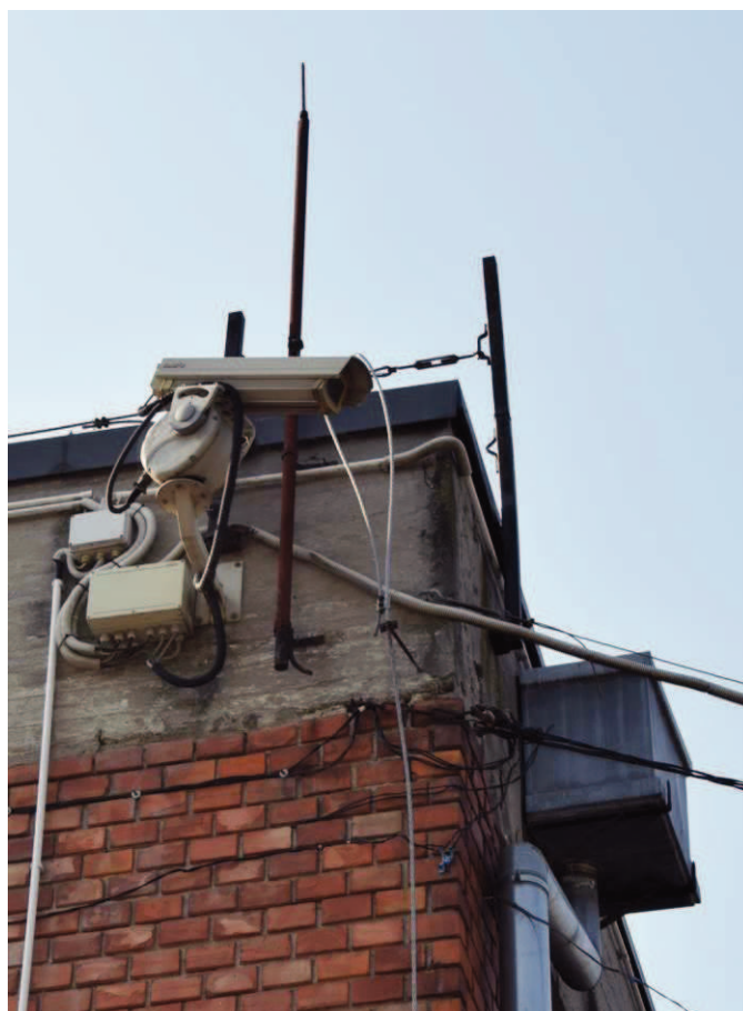
Vasbeton mellvédsáv, biztonsági kamera, villámhárító, ereszcsonna a középső épület sarkán.
