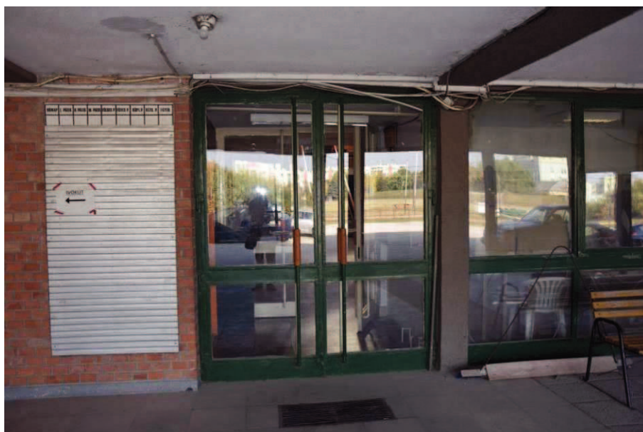
A klubház bejárata. Vasszerkezetű szabványkapu az 1970-es évekből.
