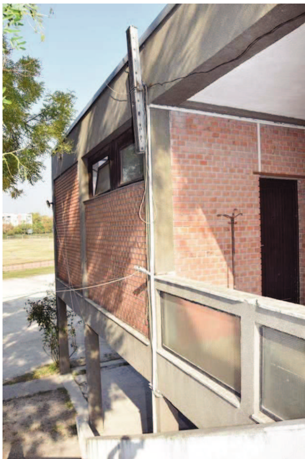
A loggia beépített északnyugati része.
