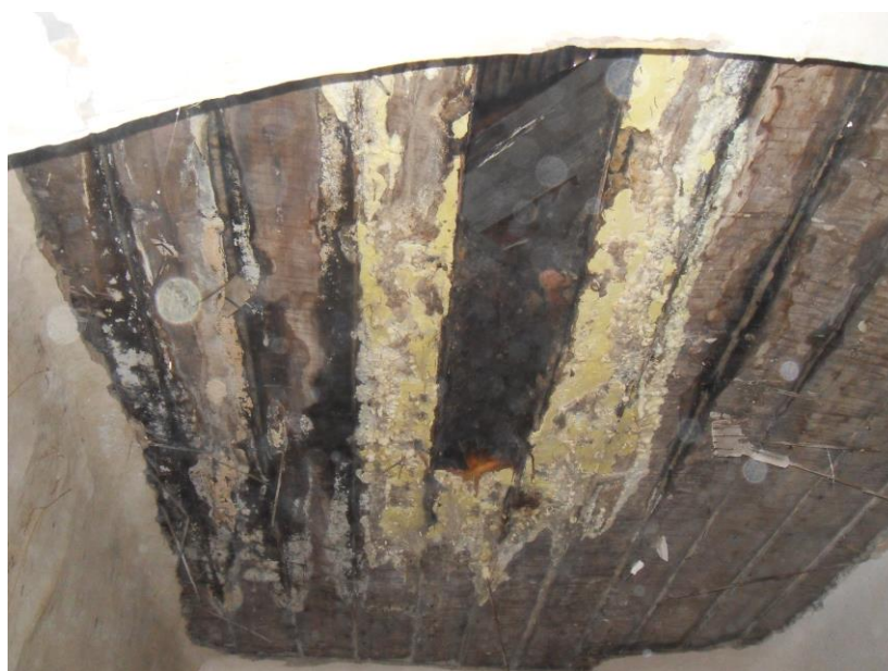
6. ábra Faföldem gomba károsodásai
