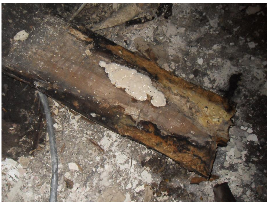
5. ábra Pince földem gomba károsodásai
