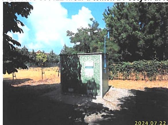
A gázfogadó állomás felépítménye Pöstyén u. felől
