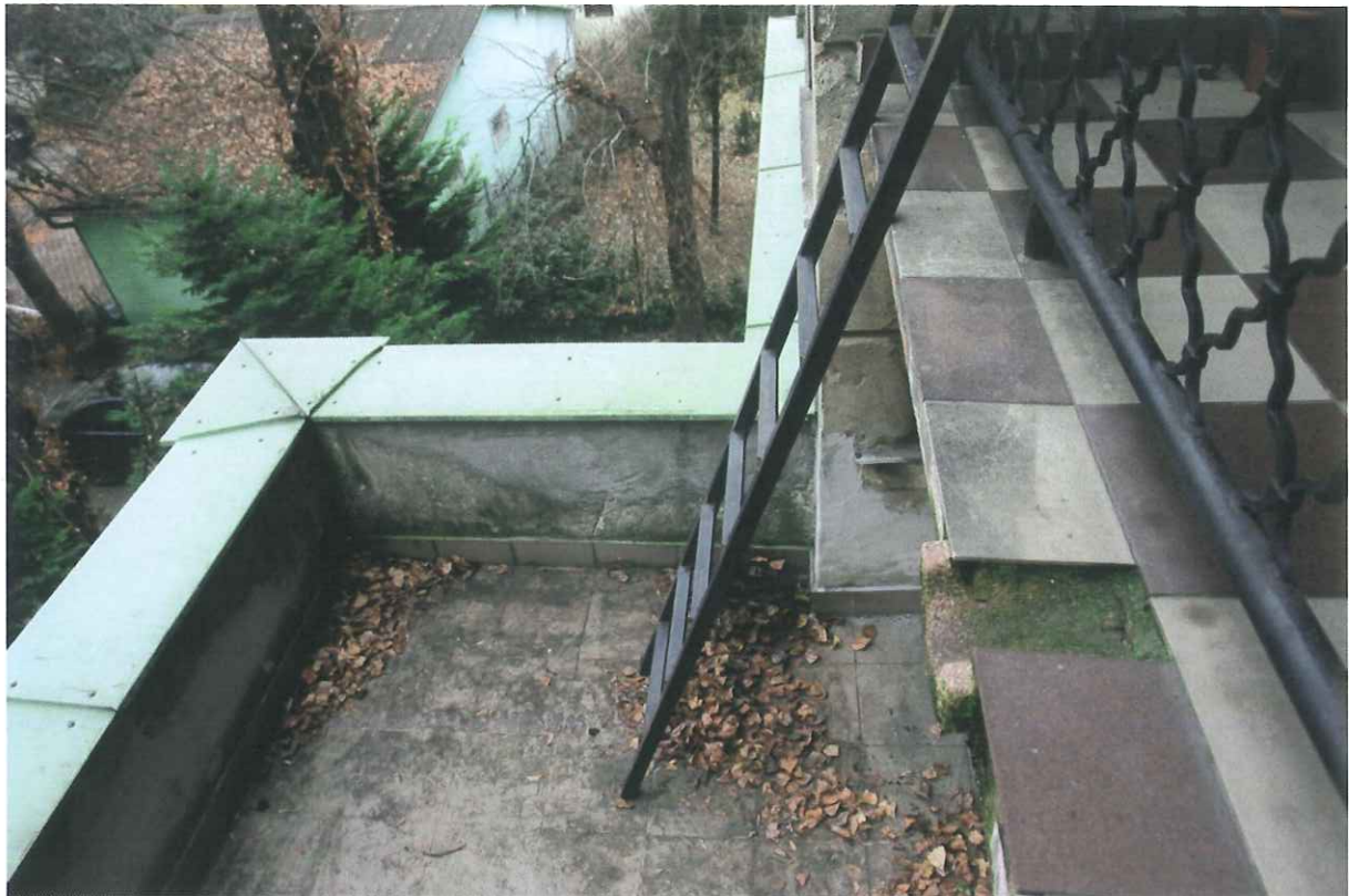
7. kép: A bejárat rész teteje (a vízszigetelés javításának helye)
