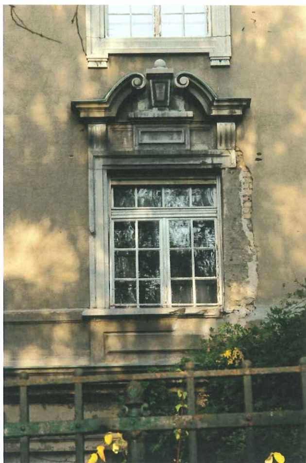
10. kép: Főhomlokzati ablak sérült könyöklővel hiányzó szárkővel
