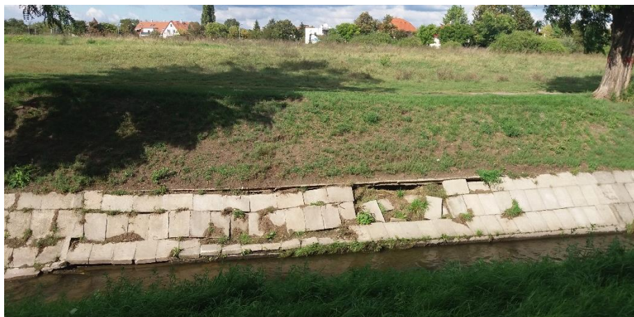
1. kép Sérült mederburkolat 5+690 szelvénynél
