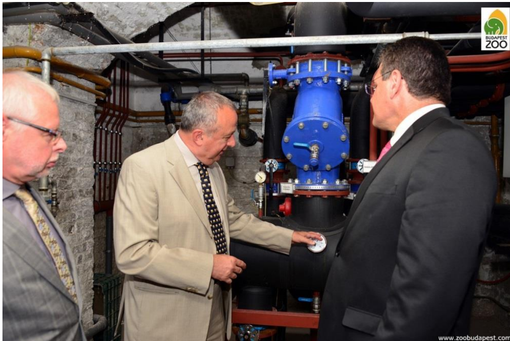
Az Állatkert területére érkező hőhordozó víz fogadóállomása
