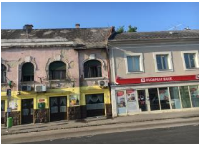
az értékelendő ingatlan és közvetlen környezete
