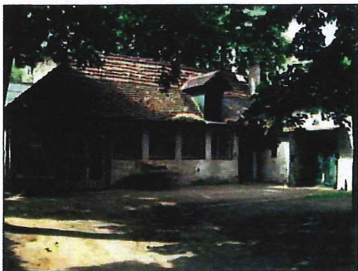
A hátsó udvarban álló értékelt műhely épület
