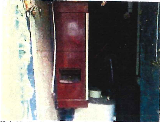
Külső bejáratta gázkazánnak tároló
