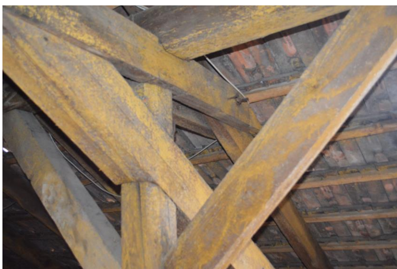
2. kép - Faanyag károsodása
