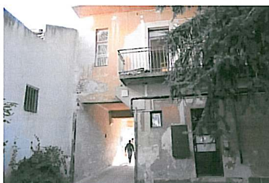
6. fénykép Belső homlokzat
