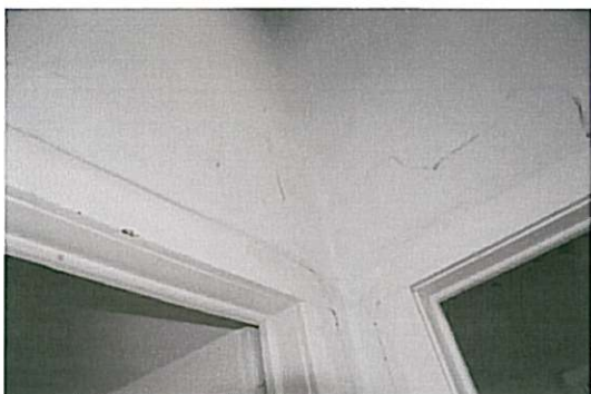
9. fénykép Repedések
