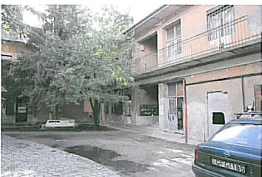
5. fénykép Belső homlokzat
