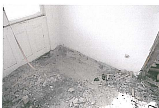
24. fénykép Vasbetonfödém feltárása
