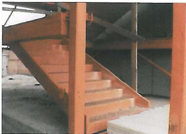
A lépcső szerkezete építés közben – 1979
