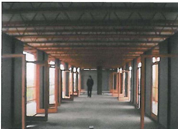
Az egyik emeleti szint a határoló szerkezetek megépülte után, a válaszfalazás előtt – 1979
