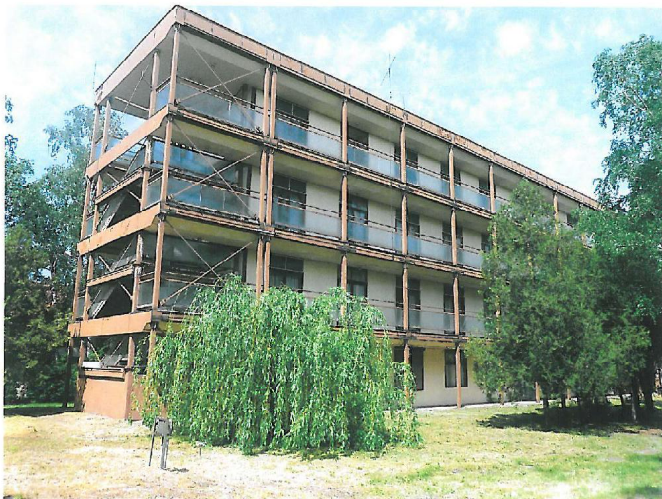
A négyszintes épületrész keleti homlokzata
